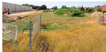
Auf dem Gelände an der Ecke Gausebrink/Witthagen entsteht eine neue Kita. Foto: Anne Stevens
